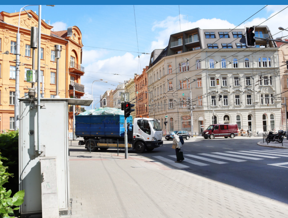
Finální testování na lokalitě Brno – křižovatka Úvoz a Údolní.
